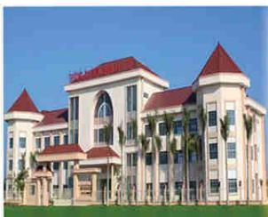
KHU A&B - Khu nhà học
