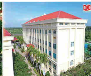
KHU D - Khu nhà học
